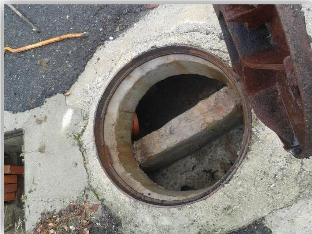
Figura 3: pozzetto di separazione acque nere e bianche
